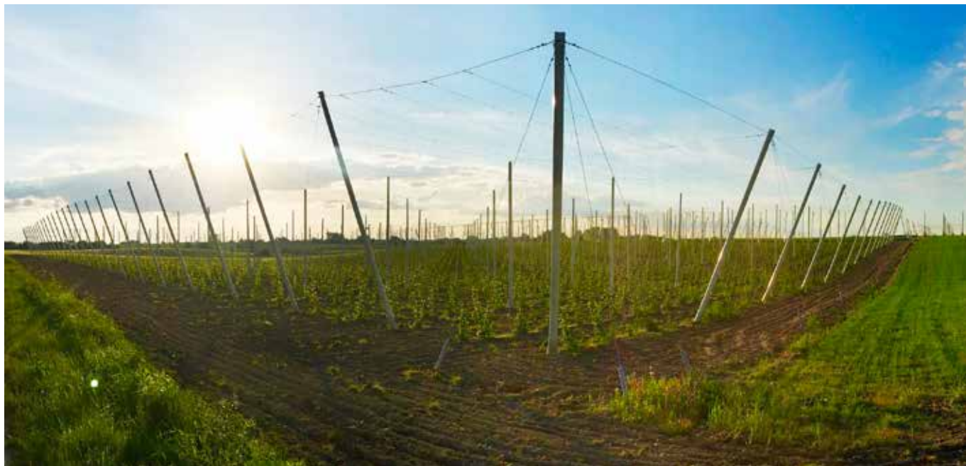
Konstrukcja chmielnika kompozytowego – młody chmiel na przełomie maja i czerwca
