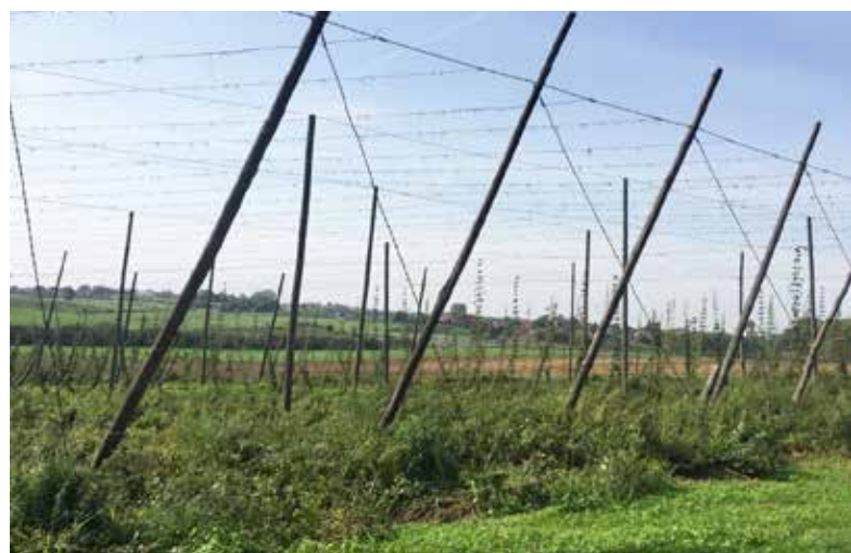
Tradycyjna konstrukcja chmielnika na słupach drewnianych impregnowanych kreozotem
